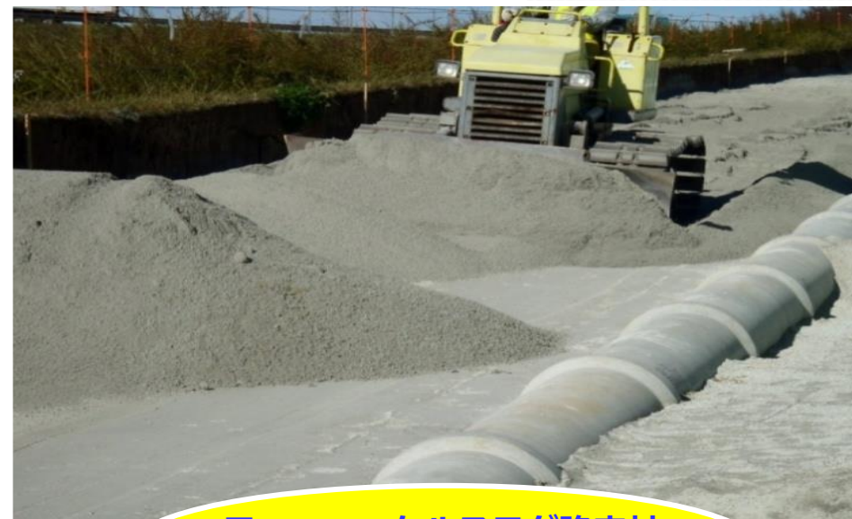
フェロニッケルスラグ路床材 施工状況
