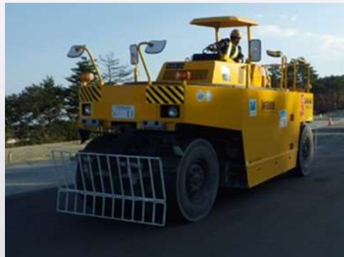
道路の舗装材としての利用
